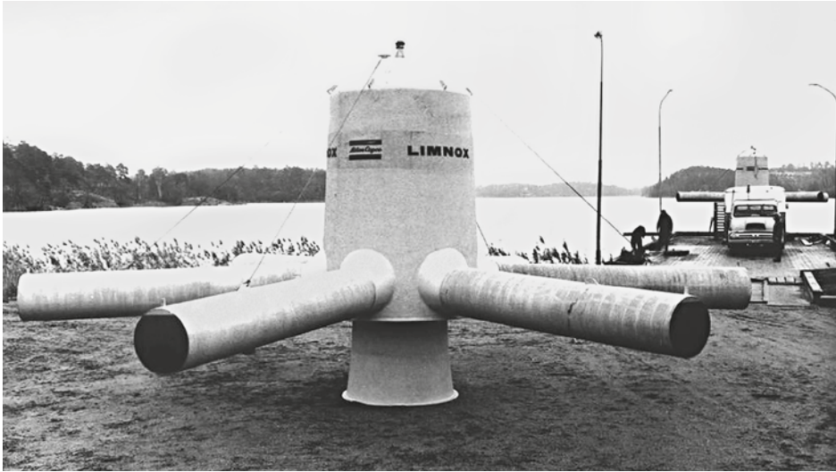
En av de Limno-luftare som användes i Brunnsviken 1973–81. Vatten drogs med tryckluft in i öppningen nertill och det syrsatta vattnet strömmade ut genom de horisontella rören. Fotograf okänd.
