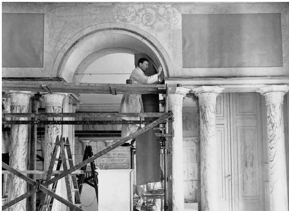
Spegelsalongen i Gustav III:s paviljong under pågående konserveringsarbete. Foto Slottsarkitektkontoret, Stockholms slott.
